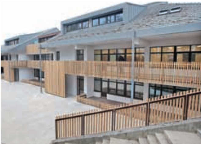
Največja naložba iztekajočega se leta in preteklega mandata je energetska sanacija in rekonstrukcija Vrta Bled.
