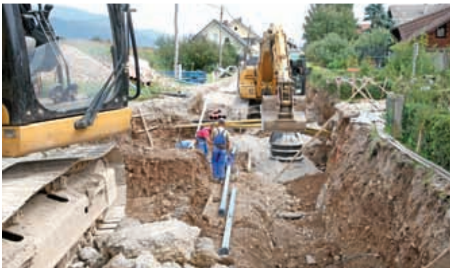
Gradnja fekalne kanalizacije v severnem delu občine
