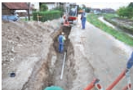
Gradnja kanalizacije na Veselovem nabrežju v Mengšu
